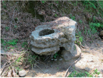
図44 5トンデリックを立てた基礎であらうか？
