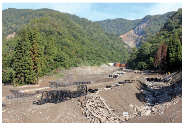
長野県北部地震による中条川の被害
