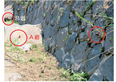
図58 石積に打たれたアイボルト (図56) と下の岩に打ち込まれたアイボルト
