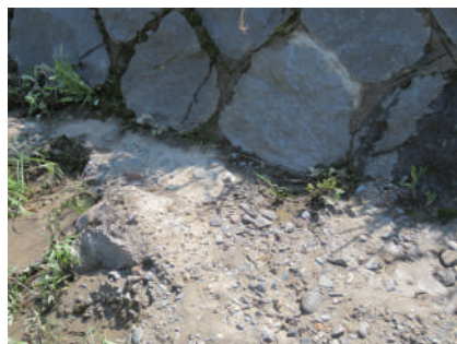
図39 石積の基盤には、コンクリートが打たれていることが確認できる
