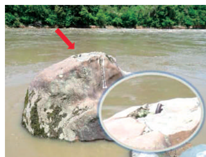
図55 流れの中にある岩のてっぺんに鉄筋が打ち込まれていた
