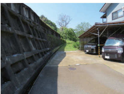
図50 軌道跡の出口付近。現在は住宅地になっている
