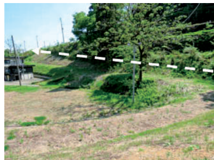
図48 新しい堤防の北側。この付近から緩い坂道となって、軌道が登っていく
