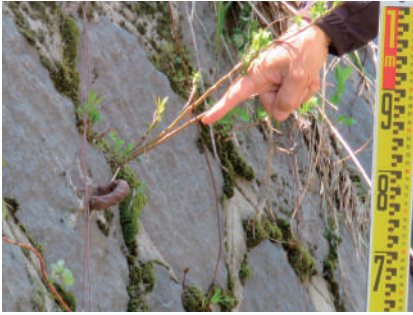
図56 石積に打ち込まれたアイボルト。ここから下流側に小さな穴が続く
