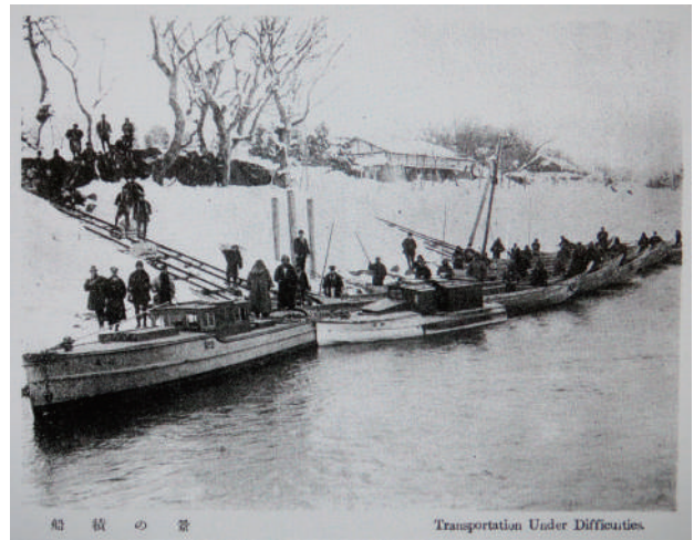
図30 信越電力会社材料運搬設備で飯山河岸から材料を船積みする様子
