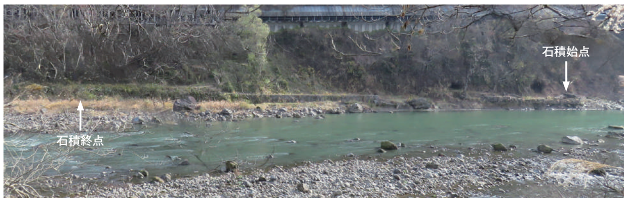
図34 対岸の田中集落側から撮影した石積の全容。現在も当時と同じ83間 (約150m) の石積が残る
