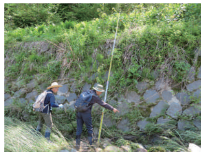
図40 図33⑤付近。石積の高さは、約3.5mある
