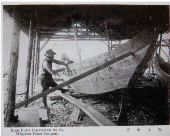
図29 材料運搬用の造船工場の様子
