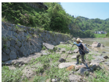
図35 図33④付近では石積の高さは基盤から高さは約2.2m
