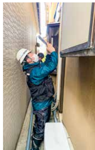
住家被害調査の様子
