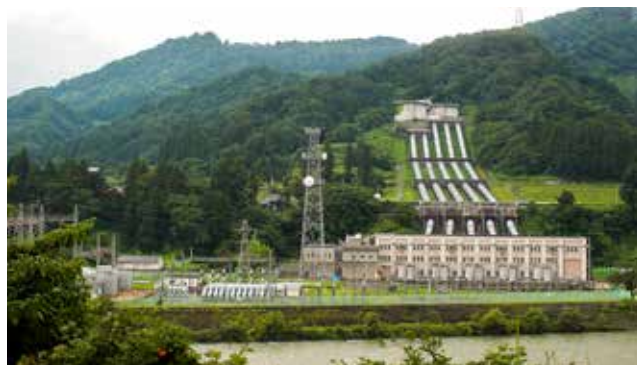
信濃川発電所
