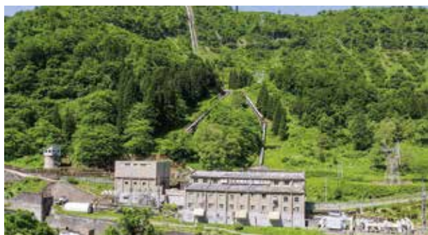
中津川第一発電所
