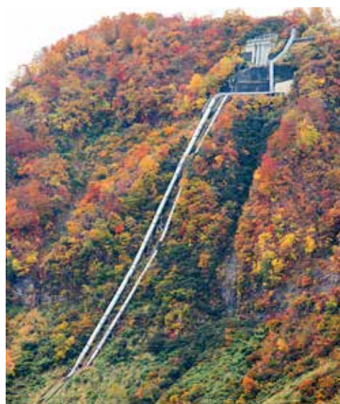
地形の高低差を利用した水力発電は 有力な再生可能エネルギー
