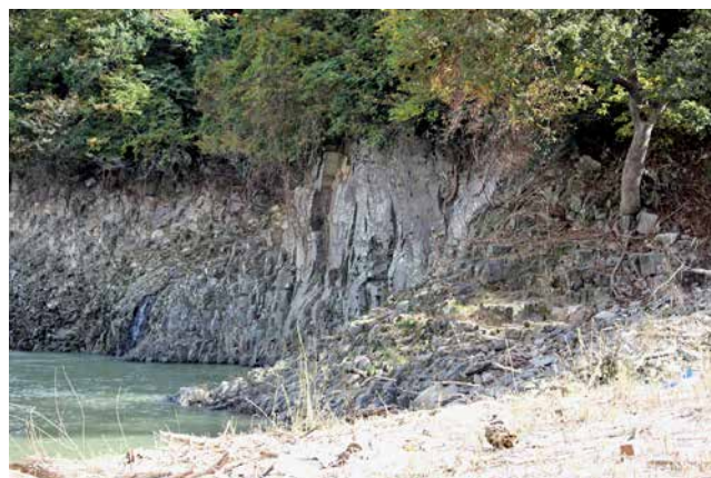
写真3 大巻地内 柱状節理（千曲川右岸）
