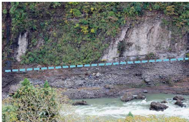
写真5 洪水後の栄村役場前の大露頭（2019年11月5日）
