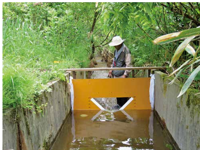
図11 三角堰による水量観測（2018.6.5）
