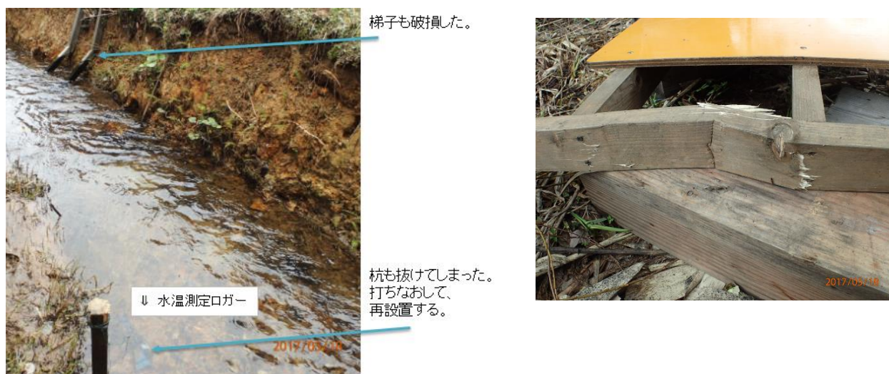
図-20 2017. 5. 18 撮影 水温測定ロガーの設置場所（左）、水量計測用堰板の破損（右）
