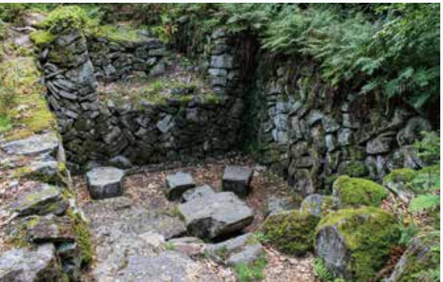
山伏山の風穴と周辺の植生・養蚕卵保管施設跡
